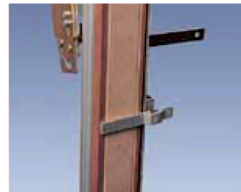
Закріплення дверної коробки в шаблоні
