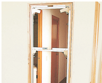
Встановлення шаблону PB83E врівень з прорізом
