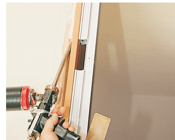
Заповнення поліуретановою піною
