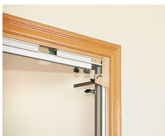
Встановлення лиштви за допомогою відповідних упорів
